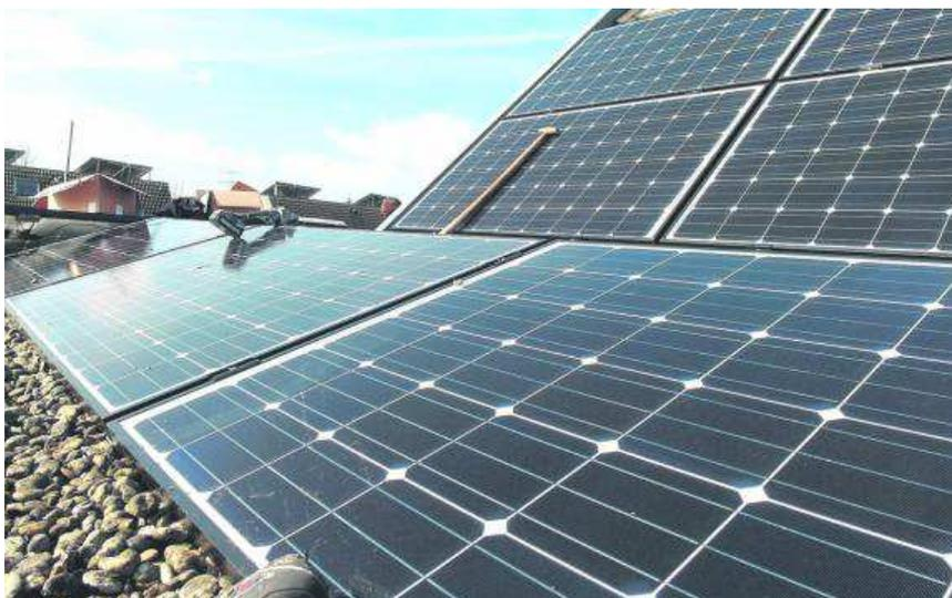
Placas fotovoltaicas para autoconsumo instaladas en la cubierta de una empresa industrial **C7**
