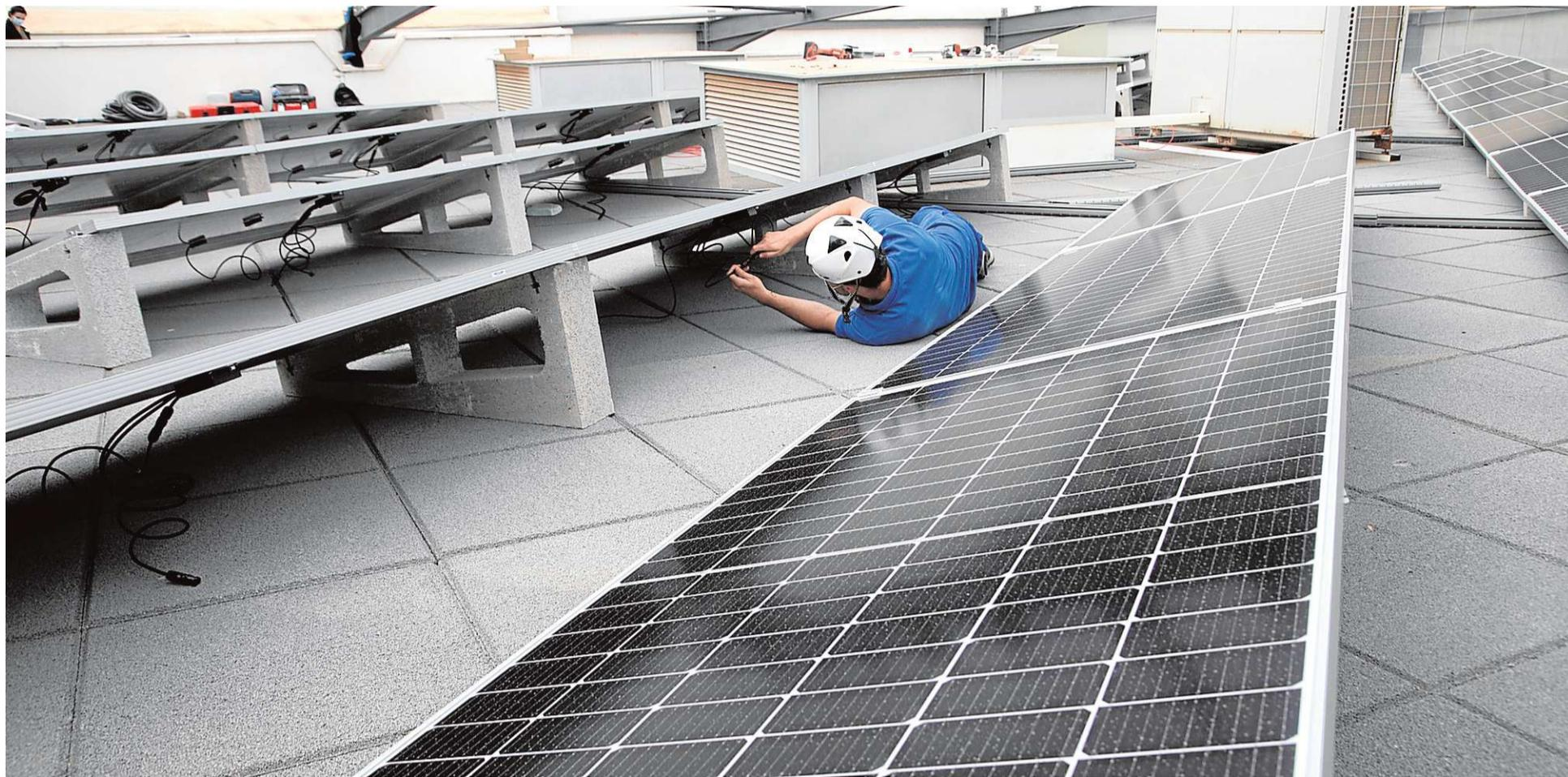
Instalación y enganche de placas solares en el techado del edificio en Arrecife de la Cámara de Comercio de Lanzarote y La Graciosa. **CARRASCO**
