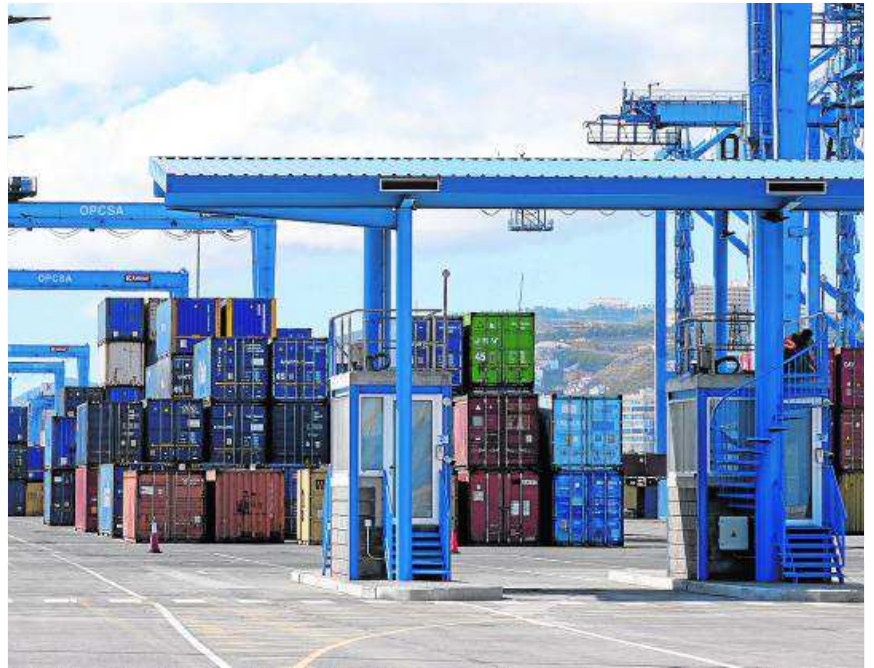
Imagen de la terminal de contenedores de Opcca, en la capital grancanaria. COBER
