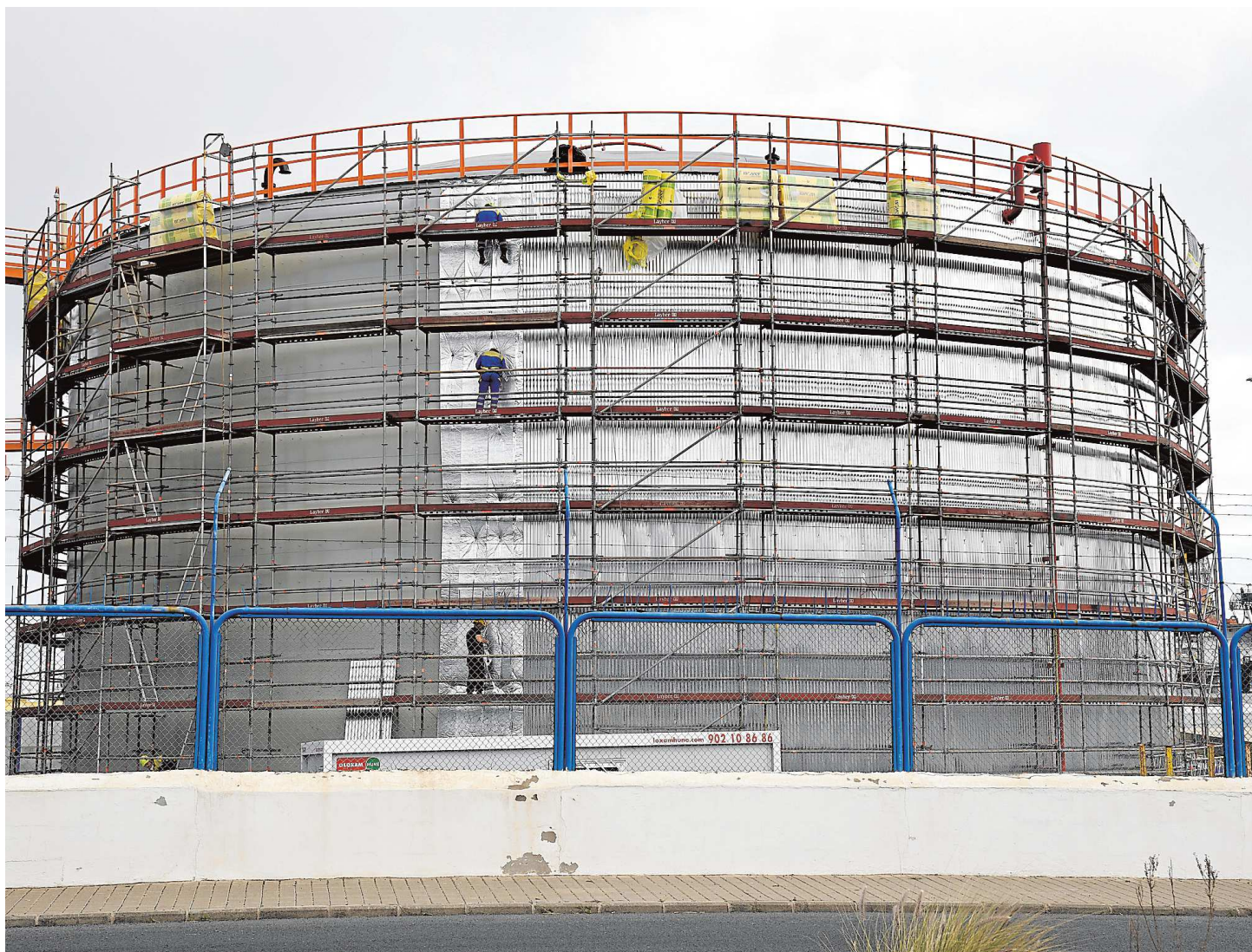
Operarios trabajan en un depósito de combustible en el puerto de la capital grancanaria. ARCADIO SUÁREZ
