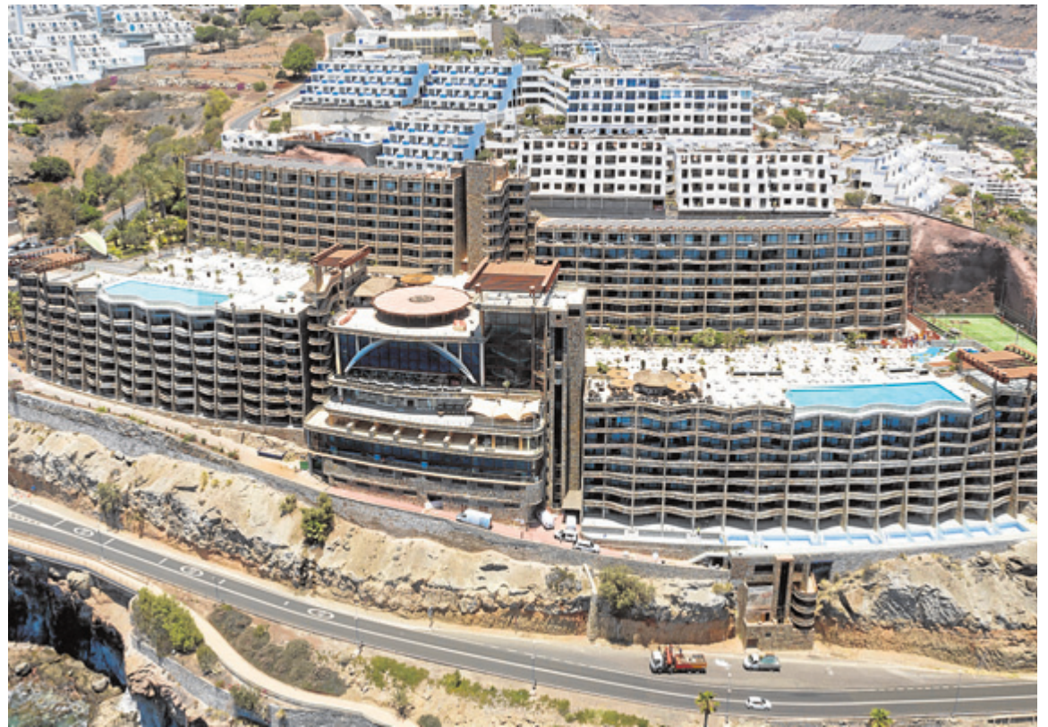
Imagen del Gloria Palace Amadores Thalasso & Hotel, que cuenta con una planta fotovoltaica y de biomasa. c7
